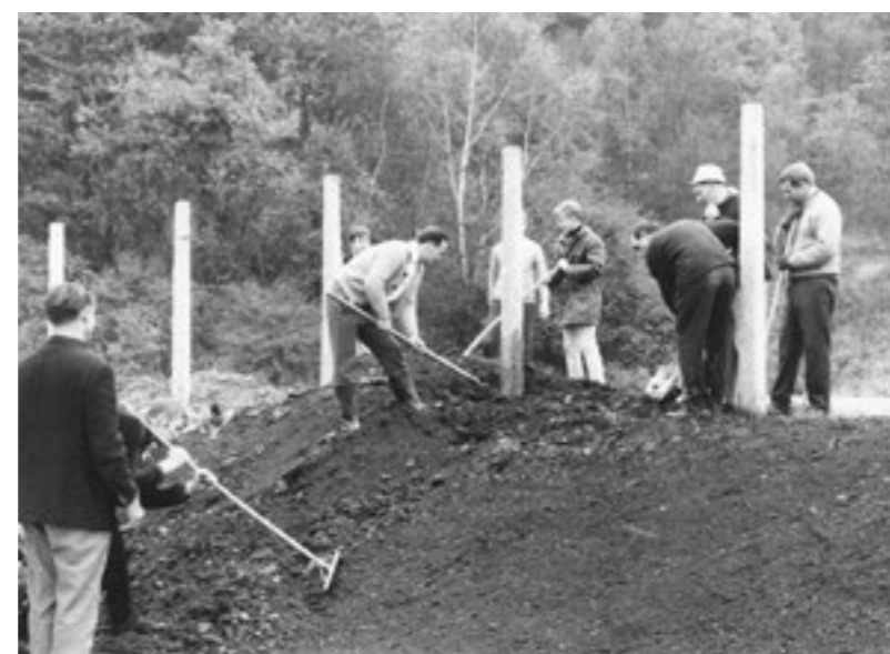
Beim Bau der neuen Anlage 1968/9
